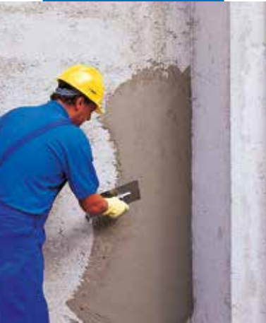
Påføring med stålbrett
